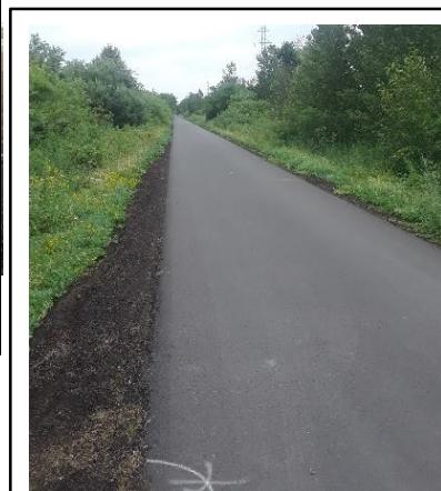
Finalisation des travaux d'asphaltage de la piste cyclable (1 er portion +/- 4 km)
