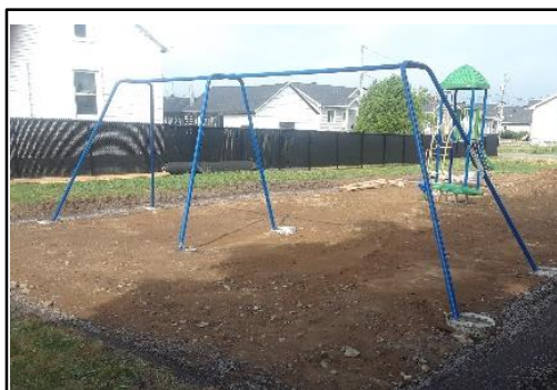
Parc pour enfants (secteur rue Talbot) en construction
